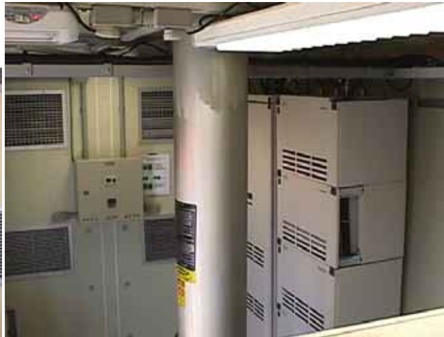
Sistema de controle de Ar Condicionado, Mastro e ERB Ericsson
