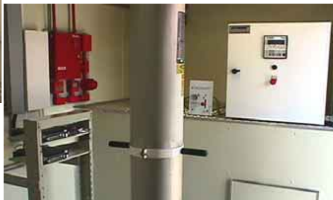
Modems HDSL, Sistema de Detecção de Incêndio, Controle do Mastro e do Grupo Gerador
