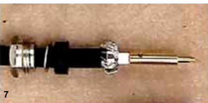
7 - Encaixe e solde o elemento central.
