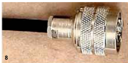
8 - Monte o corpo do conector no cabo e aperte a bucha rosqueada com uma chave de boca.
