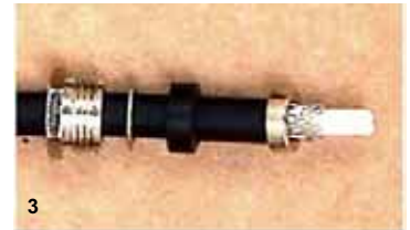
3 - Passe a bucha cônica metálica por sobre a malha - o lado de menor diâmetro voltado para a extremidade cortada do cabo.
