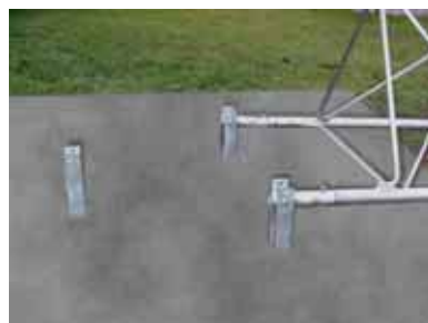
Suportes da base articulados para fácil instalação e manutenção
