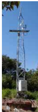
Suportes da base articulados para fácil instalação e manutenção
