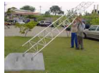
Suportes da base articulados para fácil instalação e manutenção
