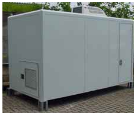
Compartimento de gerador isolado do espaço interno
