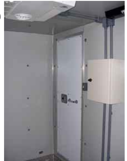
Condicionador de ar rooftop, instalação elétrica
